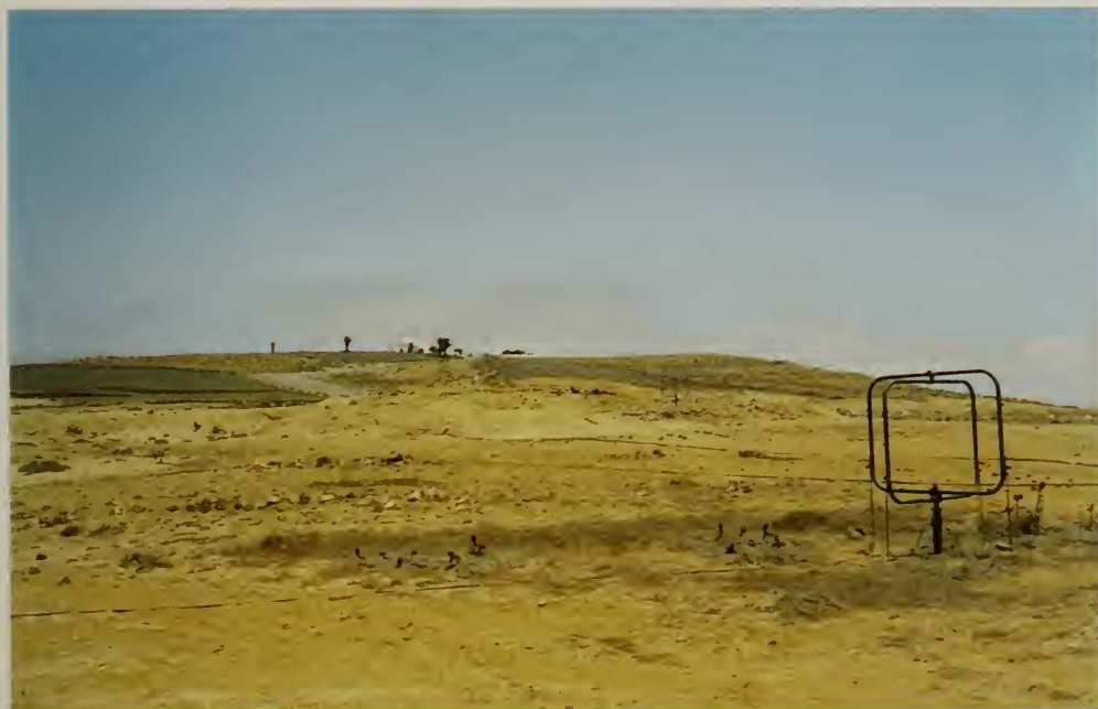
Figuras 2 y 3.- Perspectivas de las edificaciones y antenas instaladas.
